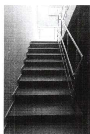
Фото № 28 Пути движения внутри здания «Лестница»
