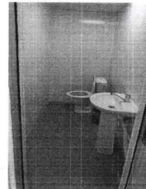
Фото № 111 Санитарно-гигиенические помещения «Туалетная комната»
