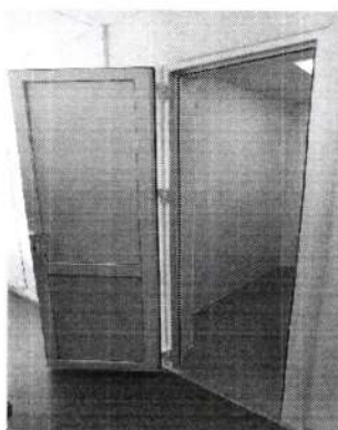
Фото № 110 Санитарно-гигиенические помещения «Туалетная комната»
