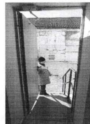
Фото № 46 Пути движения внутри здания «Пути эвакуации»
