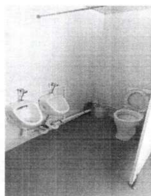
Фото № 108 Санитарно-гигиенические помещения «Туалетная комната»
