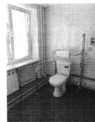
Фото № 95 Санитарно-гигиенические помещения «Туалетная комната»
