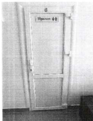
Фото № 102 Санитарно-гигиенические помещения «Туалетная комната»
