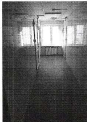
Фото № 44 Пути движения внутри здания «Пути эвакуации»
