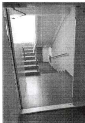
Фото № 31 Пути движения внутри здания «Дверь»
