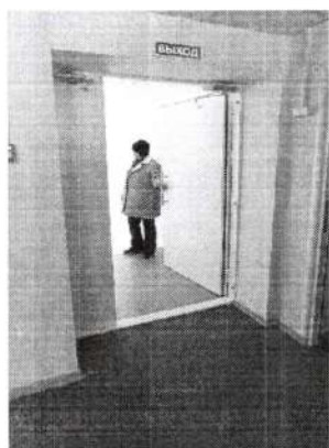
Фото № 36 Пути движения внутри здания «Дверь»
