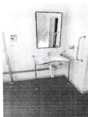
Фото № 94 Санитарно-гигиенические помещения «Туалетная комната»
