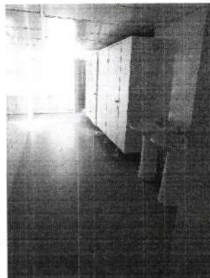
Фото № 100 Санитарно-гигиенические помещения «Туалетная комната»
