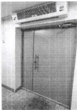
Фото № 40 Пути движения внутри здания «Пути эвакуации»
