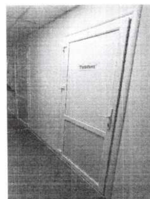
Фото № 98 Санитарно-гигиенические помещения «Туалетная комната»
