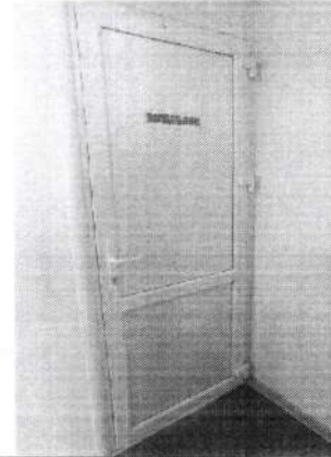
Фото № 42 Пути движения внутри здания «Пути эвакуации»
