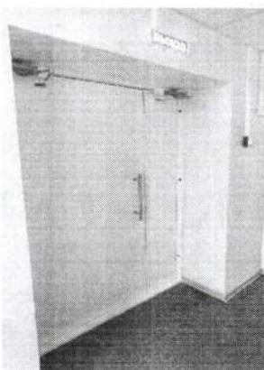
Фото № 30 Пути движения внутри здания «Дверь»
