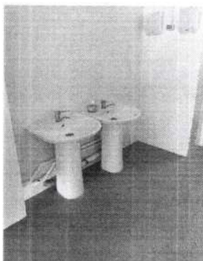
Фото № 114 Санитарно-гигиенические помещения «Раковины»
