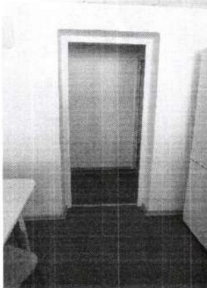
Фото № 41 Пути движения внутри здания «Пути эвакуации»
