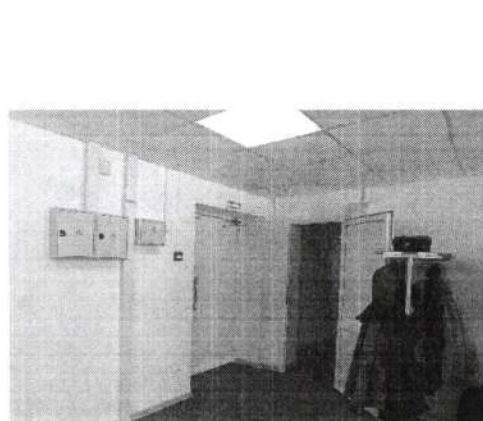
Фото № 35 Пути движения внутри здания «Дверь»
