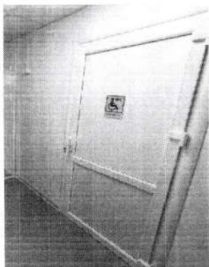
Фото № 90 Санитарно-гигиенические помещения «Туалетная комната»
