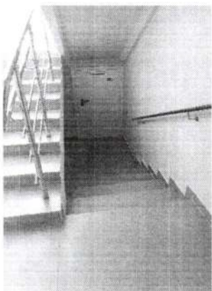
Фото № 29 Пути движения внутри здания «Лестница»
