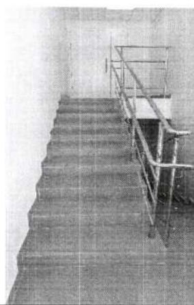
Фото № 27 Пути движения внутри здания «Лестница»
