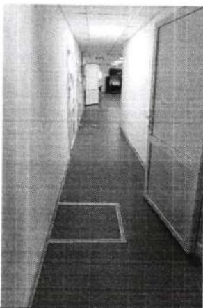
Фото № 17 Пути движения внутри здания «Коридор»
